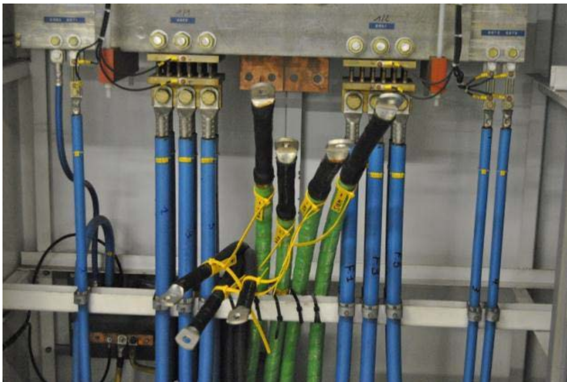
Figura 9 - Adaptação das ligações dos cabos de alta tensão para o transformador, STIB
